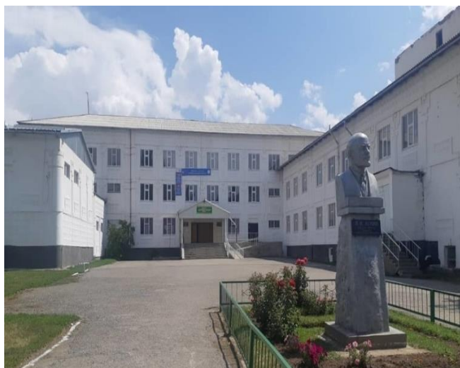
Рисунок 1 Общий вид здания СШ №1 им.В.И.Ленина
